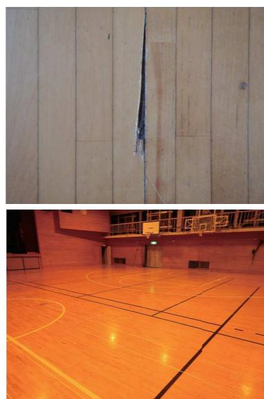
全国で体育館の床板が剥離し、バレーボールなどの運動中に生徒が負傷する事故が起きています。床板が剥がれてしまつたのは、本来避けなければいけなかつた水拭きなどが原因のようです。埼玉県でも点検により10ヶ所以上の床板劣化が発見されました。深刻な損傷の県立学校12校の体育館の床を削りウレタン塗装をしたり、床板を張り替えるなどを、今年度中に緊急実施する改修費6596万円が予算化されました。
